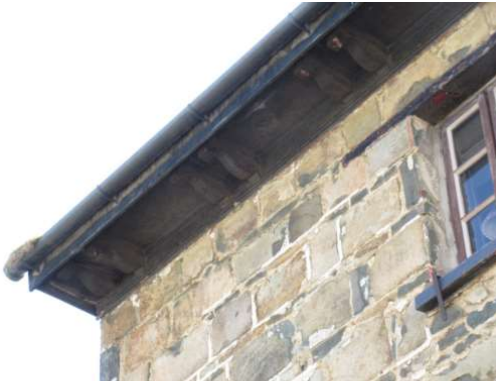
Ffigwr 55 - Bondoeau braced o ddechrau'r 19eg ganrif
