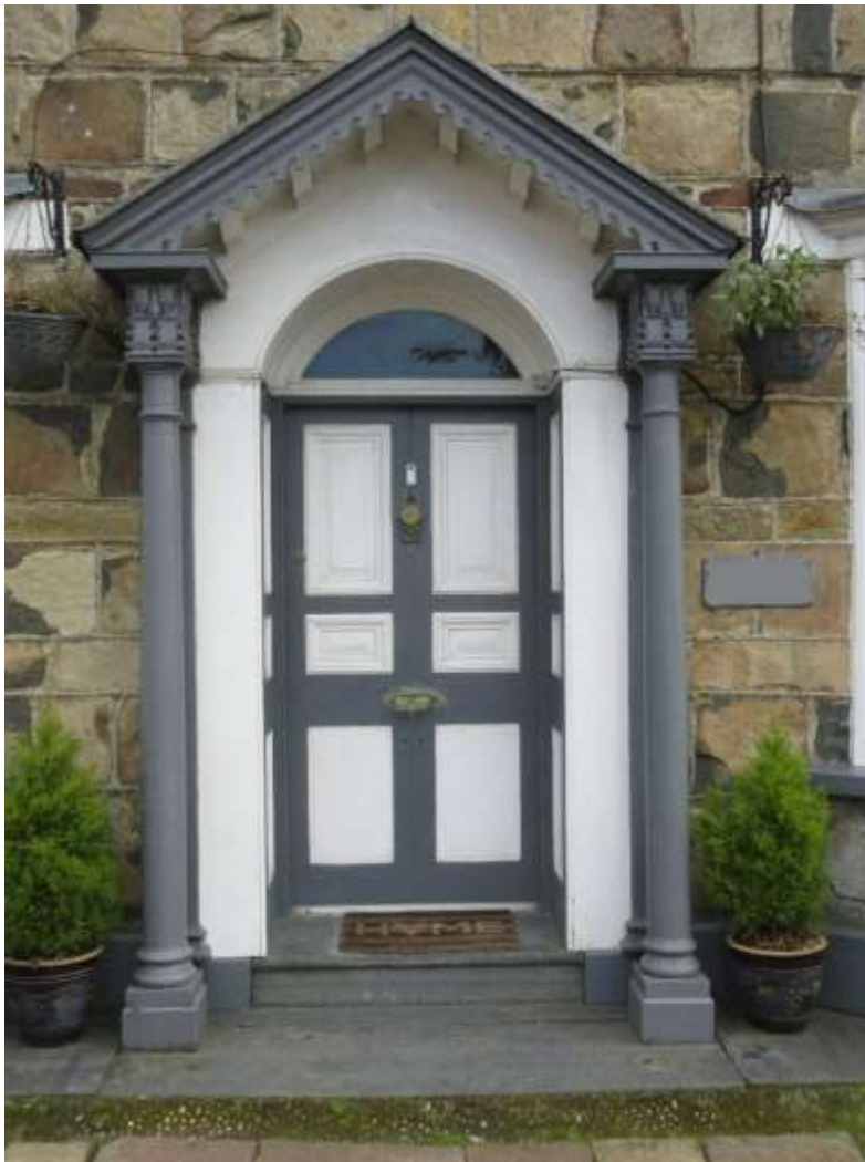
Ffigwr 48 - Ffrâm ddrws talog o ddechrau'r 19eg ganrif
